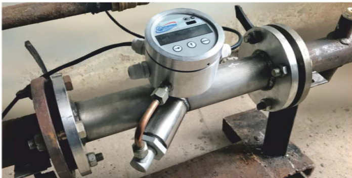
1 – преобразователь расхода; 2, 3 – датчики температуры; 4,5 – подающий и обратный трубопровод.
