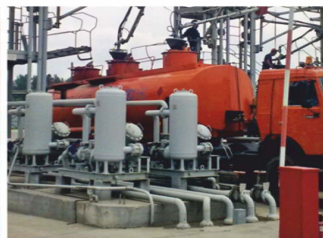
ФИЛЬТРЫ ФЖУ с давлением до 1,6 МПа для трубопроводов с Ду 150, 200, 250, 300, 350 и 400мм
