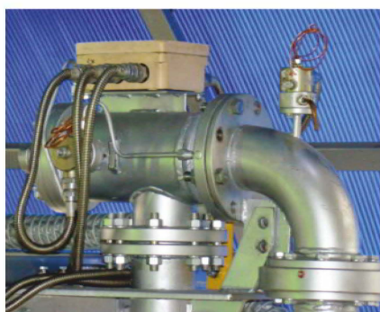
КЛАПАН СОЛЕНОИДНЫЙ, двойного действия Ду 100 835.00.00.00
