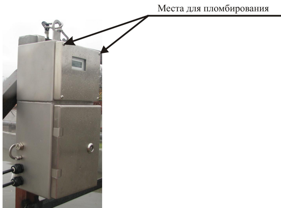
Рисунок Д.2 – Схема пломбирования модификации ГЕОСТРИМ 71П
